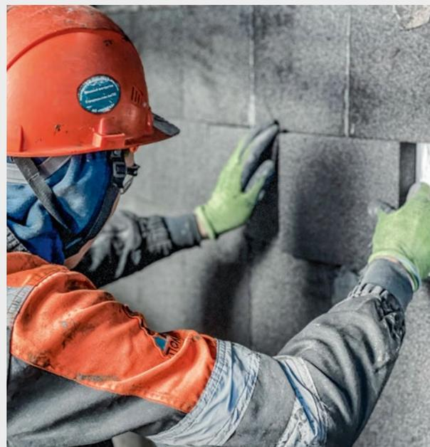
**Специалисты «ПОЛАТИ» работают с любыми видами теплоизоляционного материала:**
